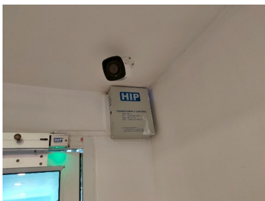
รูปที่ 3-40 การติดตั้งกล้องวงจรปิด (CCTV) ภายในอาคารโครงการ
