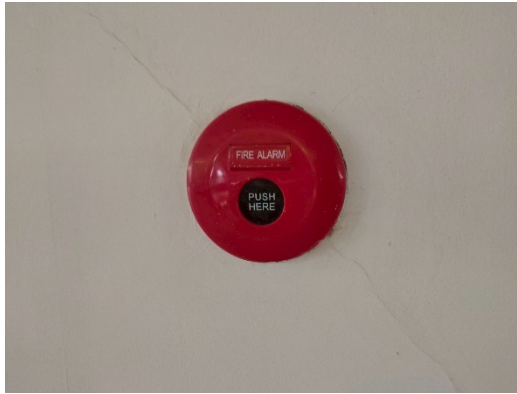
รูปที่ 3-30 อุปกรณ์แจ้งเหตุไฟไหม้กริ่งส่งสัญญาณเตือนอัคคีภัย (Fire Alarm Bell) และแผงควบคุม (Manual Station)
