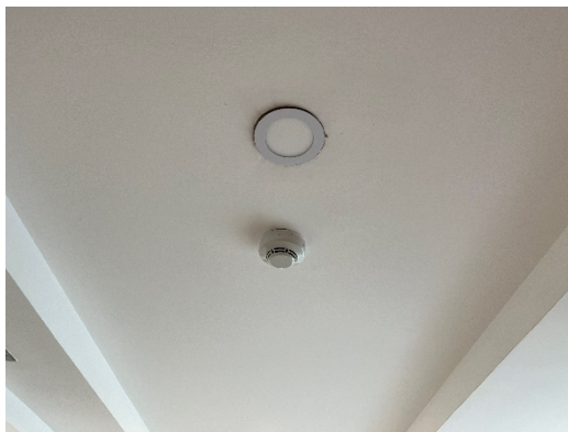
รูปที่ 3-29 อุปกรณ์ตรวจจับควัน ตรวจจับความร้อน และไฟฉุกเฉินอัตโนมัติชนิดแบตเตอรี่แห้ง
