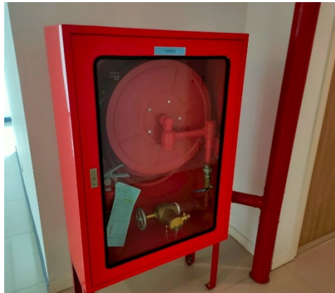
รูปที่ 3-28 ตู้เก็บสายฉีดน้ำดับเพลิงพร้อมอุปกรณ์ (Fire Hose Cabinet : FHC)
